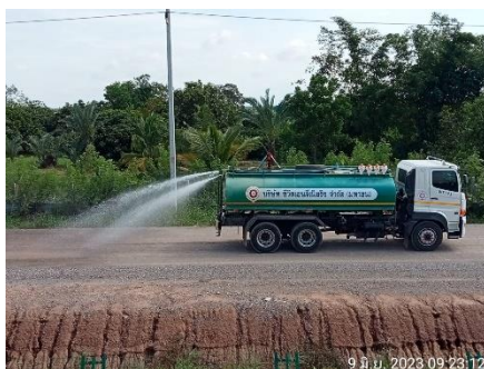
ภาพที่ 2.2-16 การฉีดพรมน้ำบริเวณพบฝุ่นละออง
