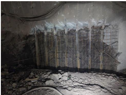
งาน Lining arch wall
