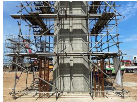
งาน Pile Cap & Column สำหรับสถานีรถไฟ
