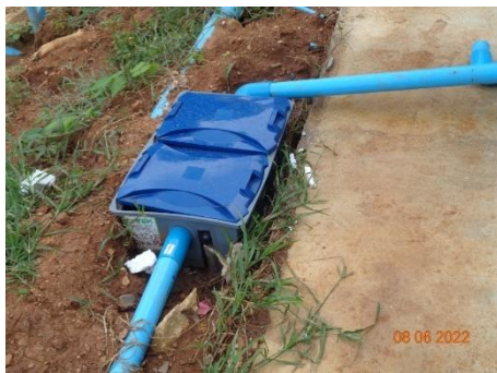
ภาพที่ 2.2-29 ระบบบำบัดน้ำเสียสำเร็จรูป
