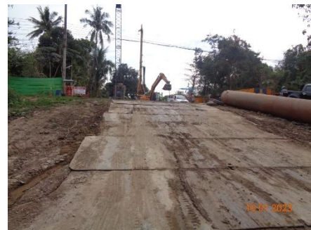
ภาพที่ 2.2-21 การใช้แผ่นเหล็กบริเวณพื้นที่ก่อสร้าง
