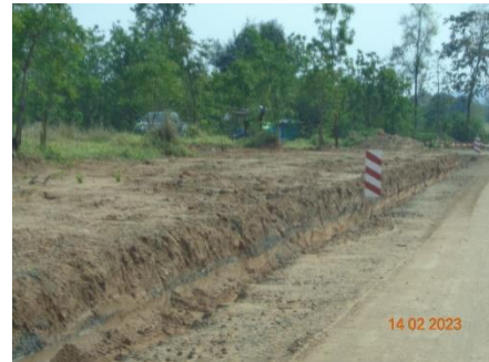
ภาพที่ 2.2-9 (ต่อ) รางระบายน้ำบริเวณพื้นที่ก่อสร้าง
