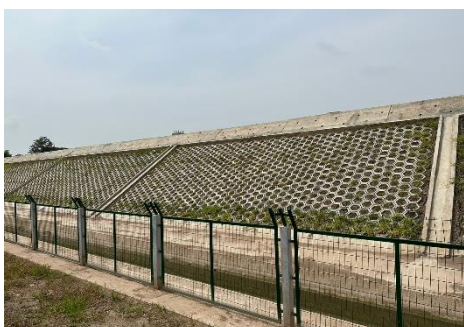
งาน Embankment Slope Protection
