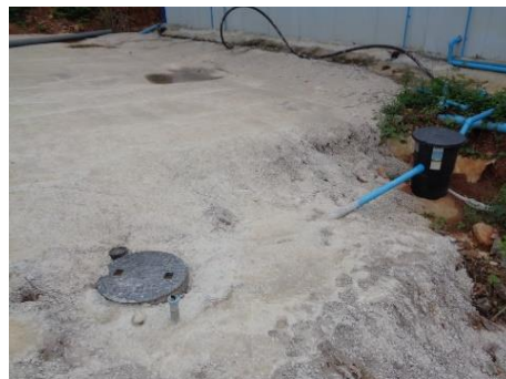
ภาพที่ 2.2-29 ระบบบำบัดน้ำเสียสำเร็จรูป
