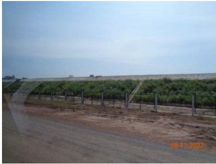
ภาพที่ 2.2-3 การปลูกพืชคลุมดินบริเวณไหล่ทาง
