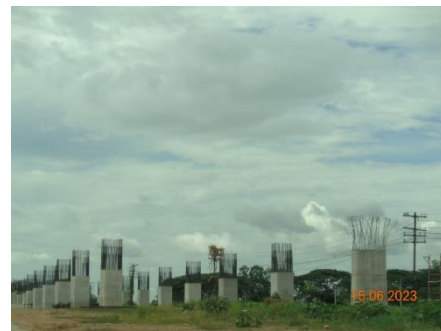
งานเข้าแบบเสาตอม่อรถไฟ
