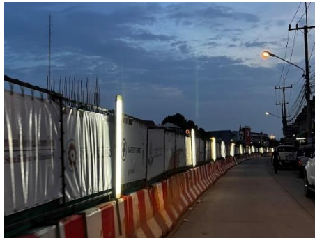
ภาพที่ 2.2-51 (ต่อ) ไฟส่องสว่างบริเวณพื้นที่ก่อสร้าง
