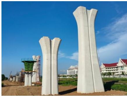
งาน Pile Cap & Column สำหรับทางวิ่งยกระดับ
