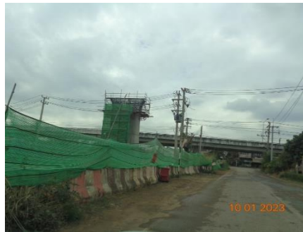
ภาพที่ 2.2-36 การติดตั้งผ้าใบกันฝุ่นบริเวณพื้นที่ก่อสร้าง
