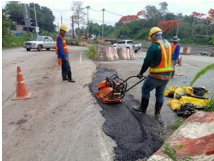
ภาพที่ 2.2-38 (ต่อ) การซ่อมแซมบำรุงเส้นทางขนส่ง
