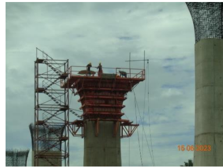
งานเข้าแบบเสาตอม่อรถไฟ
