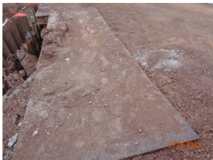
ภาพที่ 2.2-21 การใช้แผ่นเหล็กบริเวณพื้นที่ก่อสร้าง
