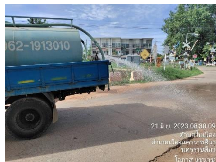
ภาพที่ 2.2-16 การฉีดพรมน้ำบริเวณพบฝุ่นละออง
