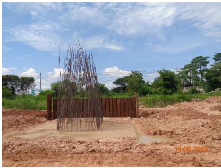
งานก่อสร้าง Pile Cap
