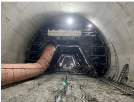
งาน Lining arch wall
