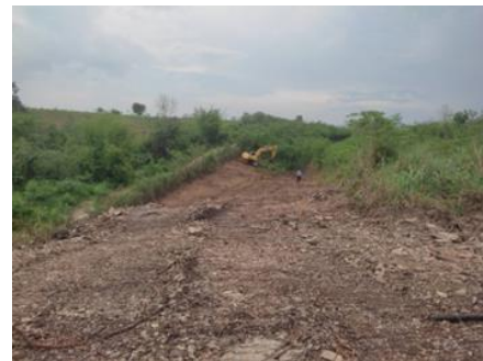
ภาพที่ 2.2-6 การเตรียมพื้นที่สำหรับก่อสร้าง
